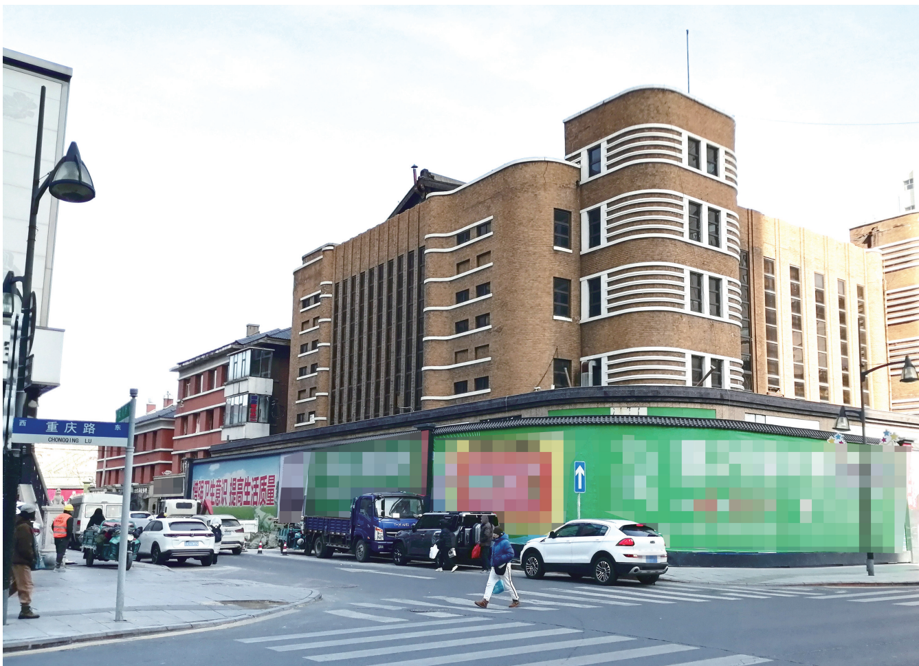
重庆路丰乐剧场即将启动修缮 本版图片 城市晚报全媒体记者 刘佳雪 摄
