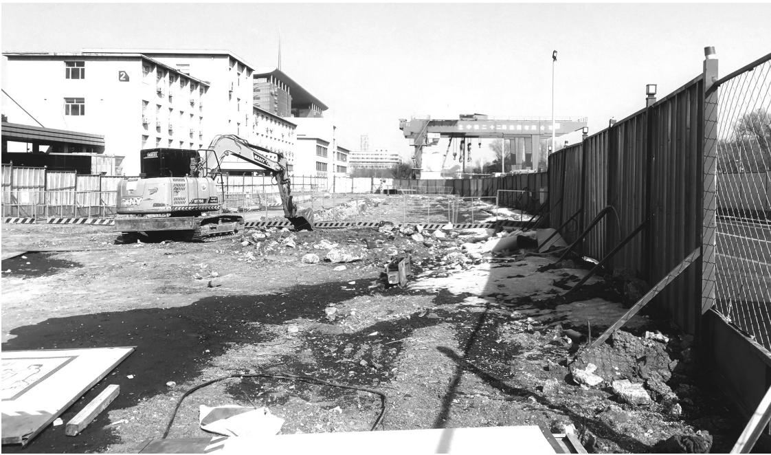
大型机械进驻工地 城市晚报全媒体记者 刘佳雪 摄
