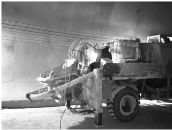
施工人员现场作业
