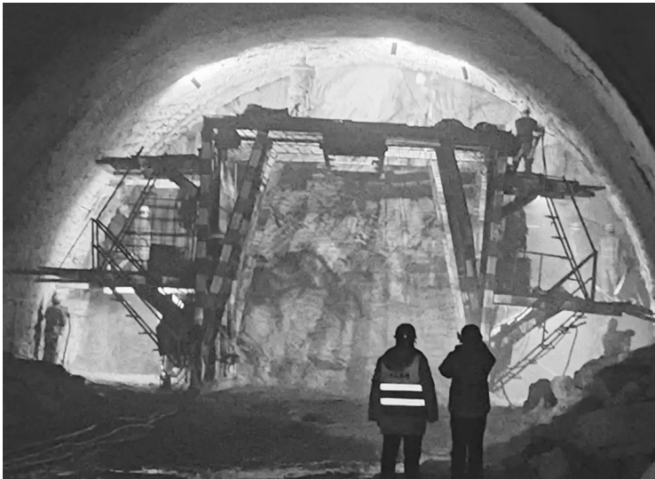
老岭隧道出口施工现场 本组图片 吉高集团供图
