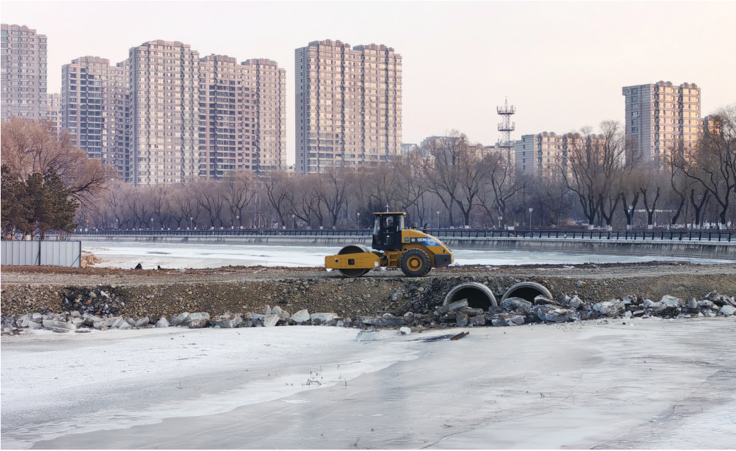
压路机正在施工 本组图片 城市晚报全媒体记者 陆续 摄
