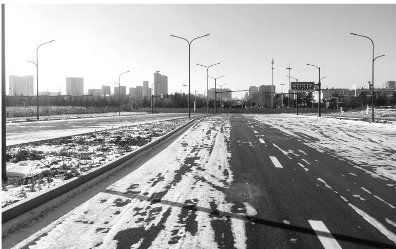
延长段沥青路面已基本施工完毕
