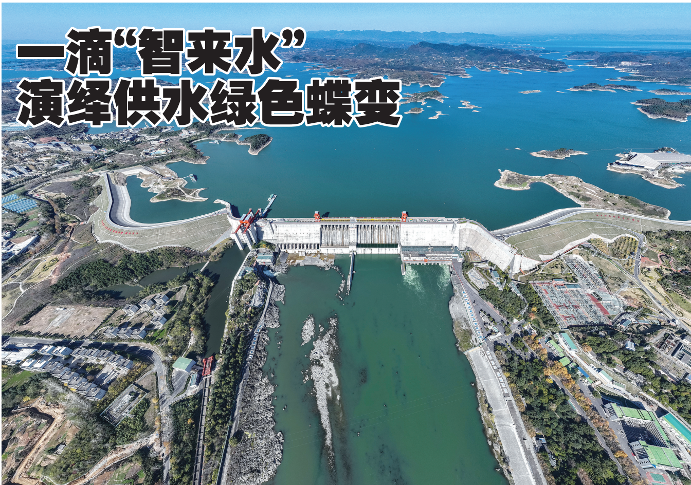
这是11月30日拍摄的丹江口大坝(无人机照片)。
