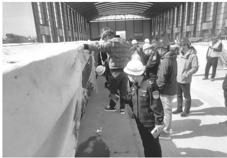
检查施工工程工艺
