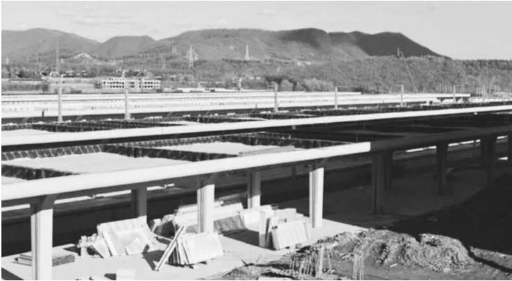
11月5日,正在建设中的通化西站。新华社发 唐铭泽 摄
