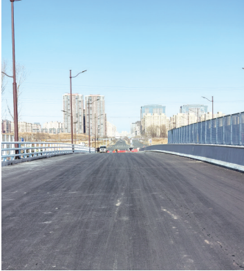
桥面已经完成了沥青铺装
