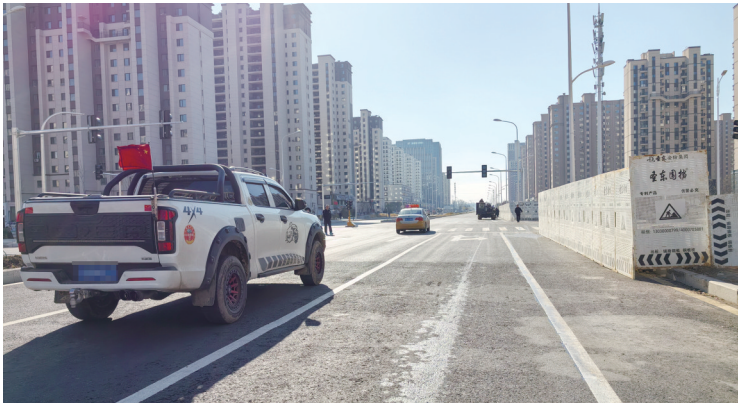
“卡脖路”西侧车行道已全面竣工通车 城市晚报全媒体记者 陆续 摄
