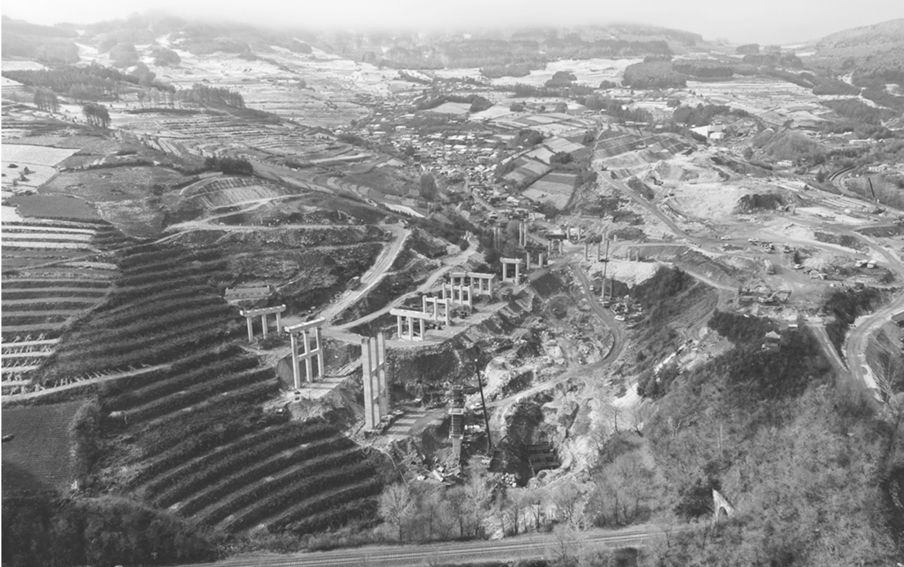
白山至临江高速公路项目松岭停车区施工现场。(资料图片)
