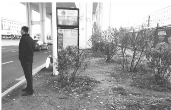
公交站台未做硬化处理
