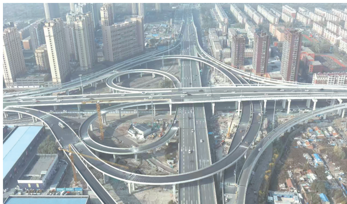
长春东荣大路互通立交桥现状 长春市建委供图
