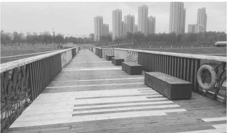
桥面破损地方已换上新木地板 城市晚报全媒体记者 吕闯 摄
