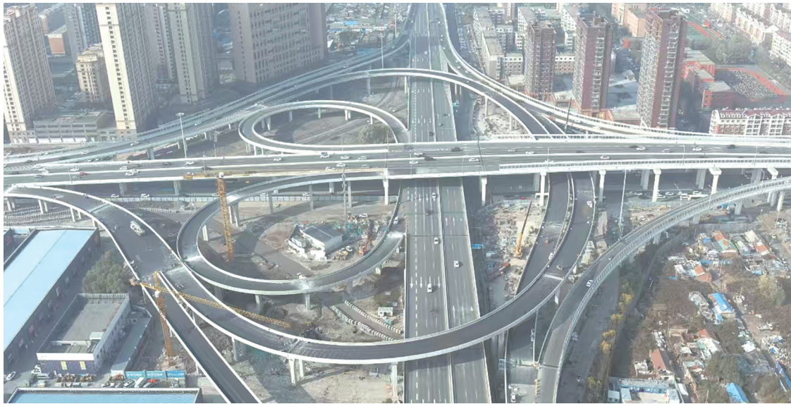
长春东荣大路互通立交桥现状 长春市建委供图
