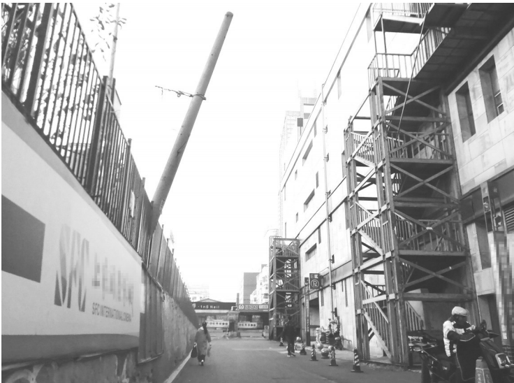
线杆倾斜严重 城市晚报全媒体记者 刘佳雪 摄
