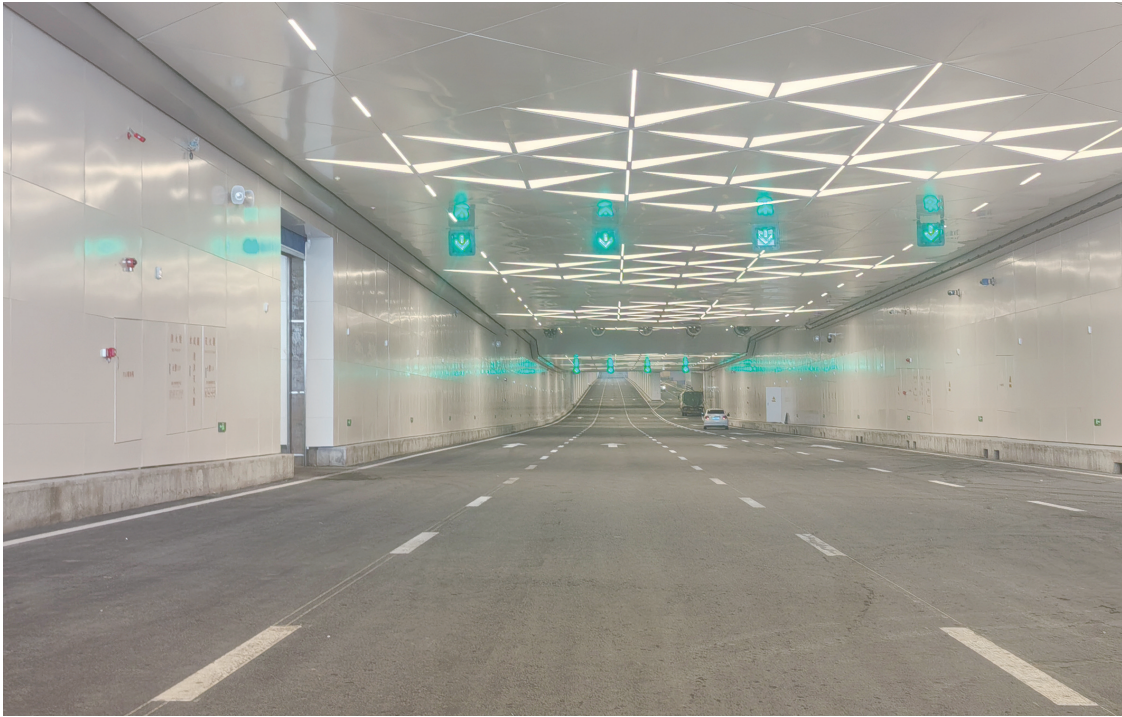
隧道内部 本组图片 城市晚报全媒体记者 陆续 摄
