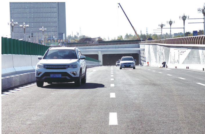
隧道外部 城市晚报全媒体记者 陆续 摄
