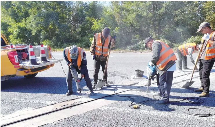
对伸缩缝进行修补 省交通运输厅供图
