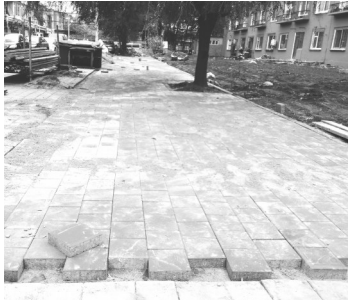
小区人行步道方砖铺设中
