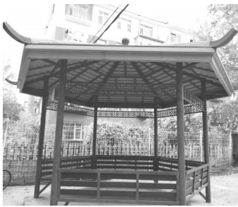
凉亭重新粉刷加固
