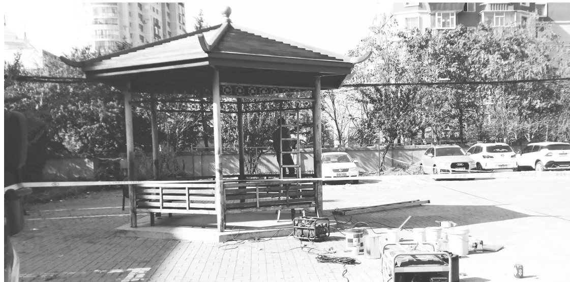
凉亭粉刷加固 本组图片 城市晚报全媒体记者 刘佳雪 摄
