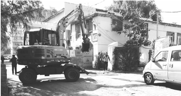
大型机械设备施工中
