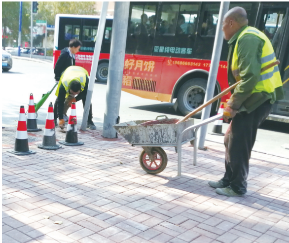
施工人员进行加速修复
