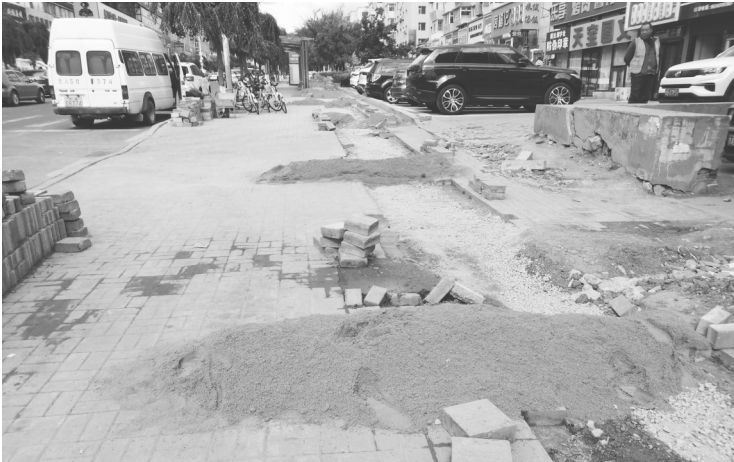
人行步道修缮中 本组图片 城市晚报全媒体记者 刘佳雪 摄
