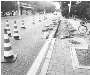
更换马路条石
