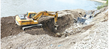
紧张推进建设
