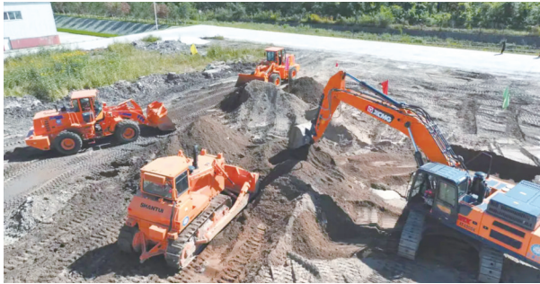
推土机模拟抢通道路 省交通应急中心供图
