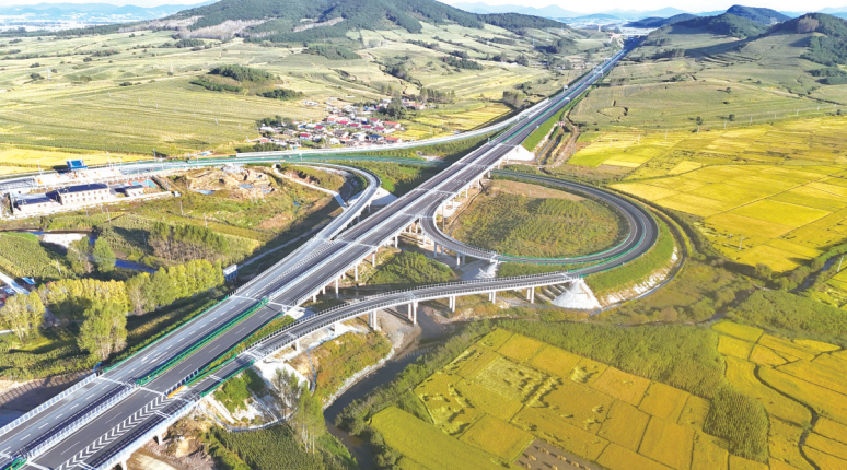
延长高速烟筒山至双阳西段 本组图片 省交通运输厅供图
