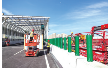
工人正在施工
