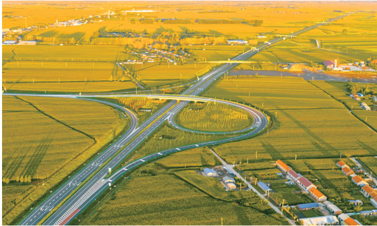
长春至太平川高速公路 本组图片 省交通运输厅供图
