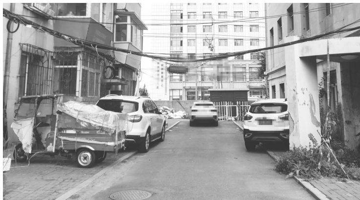
线缆垂在半空中 城市晚报全媒体记者 刘佳雪 摄
