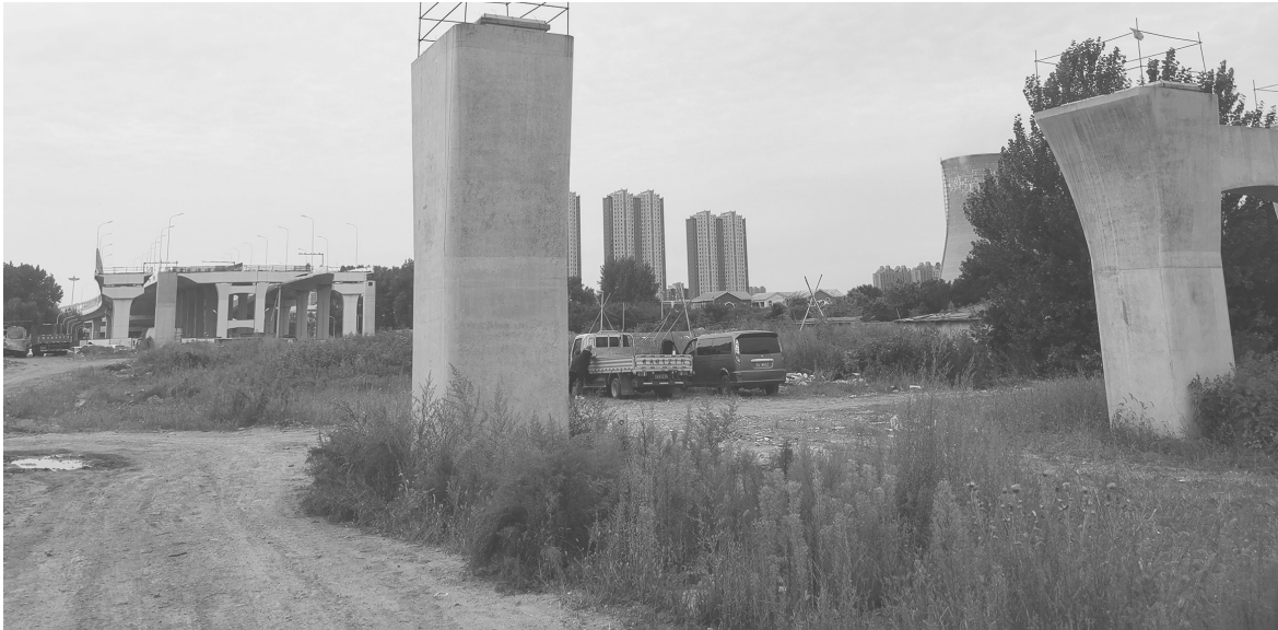
世纪大街快速路北延工程连接处 城市晚报全媒体记者 吕闯 摄
