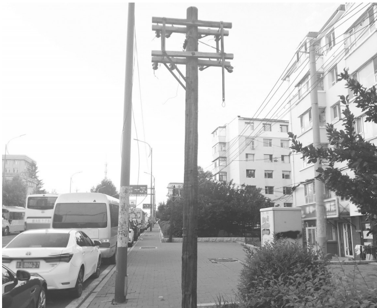
废弃线杆立在人行道旁 城市晚报全媒体记者 刘佳雪 摄
