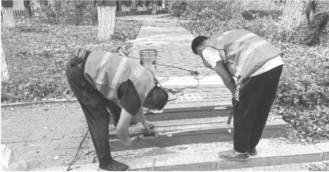
工作人员现场修复木栈道 城市晚报全媒体记者 刘佳雪 摄
