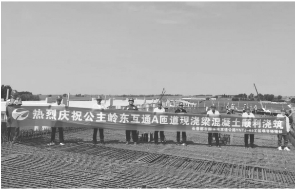
施工现场 吉高集团供图
