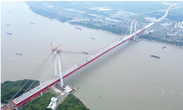
8月27日拍摄的G3(京台高速)铜陵长江公铁大桥合龙现场(无人机照片)。 新华社记者 刘军喜 摄
