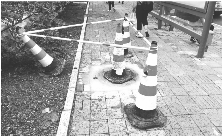
已经修复好的井盖 本组图片 城市晚报全媒体记者 刘佳雪 摄
