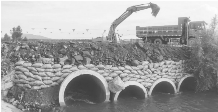
挖掘机抢险作业 省交通运输厅供图
