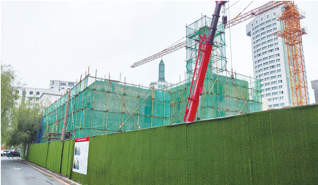
修缮现场 本组图片 城市晚报全媒体记者 陆续 摄
