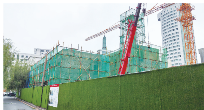
修缮现场 城市晚报全媒体记者 陆续 摄
