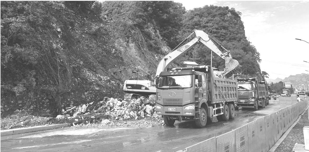
8月6日,大型机械设备在清理位于吉林省集安市下解放村一处山坡上的“落石”。新华社发
