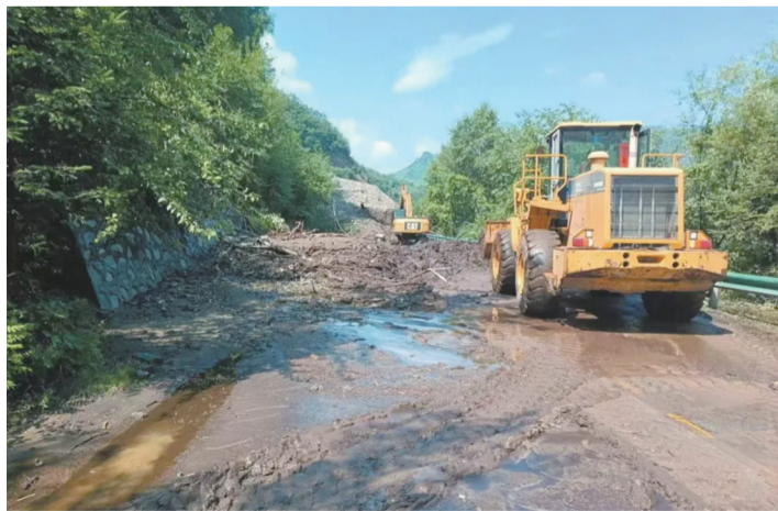
清理淤泥石块 省交通运输厅供图
