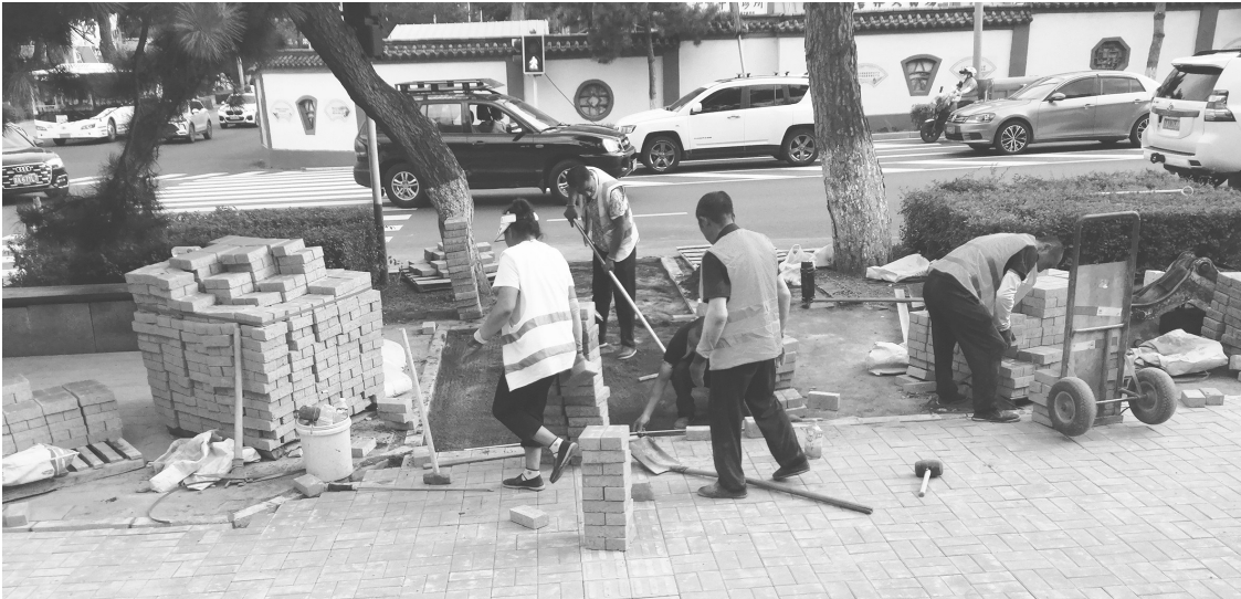
部分人行步道已经修复好 城市晚报全媒体记者 刘佳雪 摄
