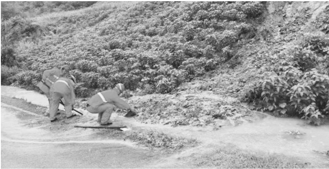
清理塌方 白山市公路处供图
