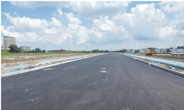
新建延长路段已完成沥青路面 城市晚报全媒体记者 吕闯 摄
