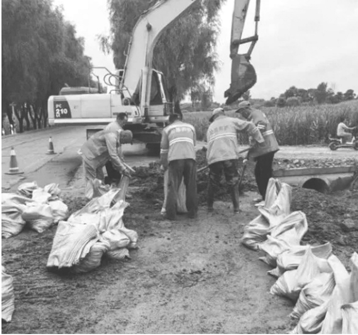
养护人员排除路面淤泥 省交通运输厅供图
