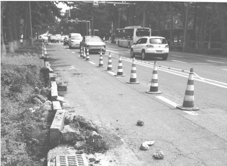
施工现场 本组图片 城市晚报全媒体记者 刘佳雪 摄
