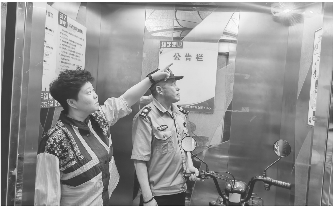
白城经开区幸福街道办事处以花园社区铂金时代小区为试点，坚持技防、人防相结合，携手环宇物业公司，共同为小区电梯加装阻车器，通过自动识别和感应，有效阻止电动自行车进入电梯，为小区居民守住了消防安全管理的“第一道关”。图为工作人员在测试安装好的电梯阻车器。 刘畅 记者 张殿文 摄
