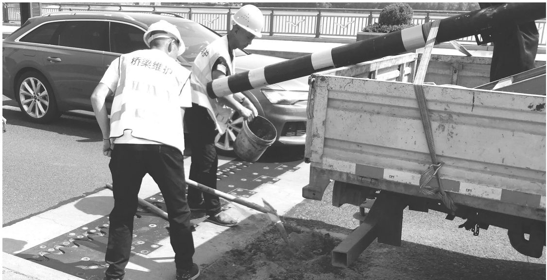
市政工人迅速修复破损路面 城市晚报全媒体记者 刘佳雪 摄
