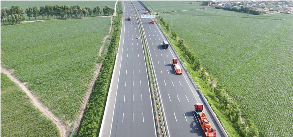
综合演练现场 省交通运输厅供图
