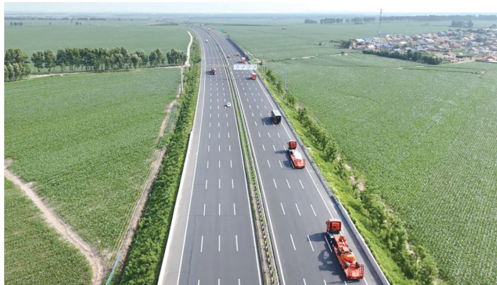
综合演练现场 省交通运输厅供图
