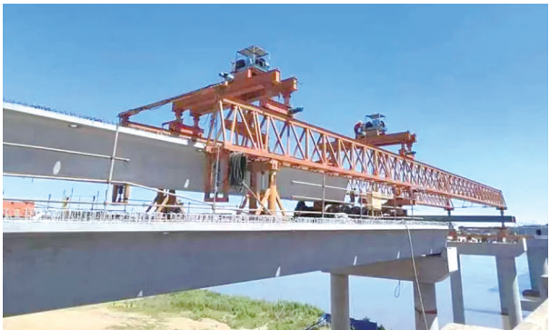
桥梁主跨施工 省交通运输厅供图
