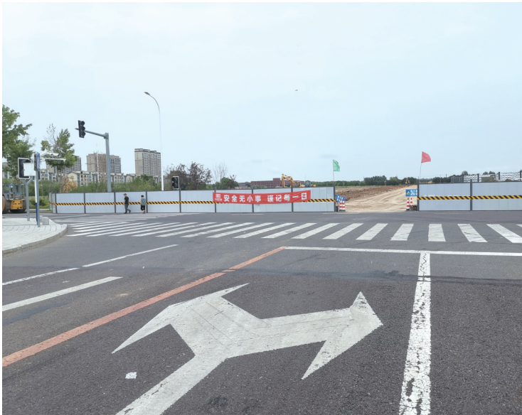
明溪路东延工程 本组图片 城市晚报全媒体记者 吕闯 摄
