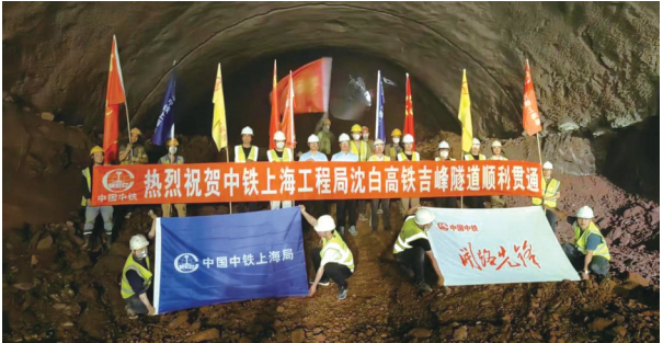
沈白高铁吉峰隧道顺利贯通 项目部供图
