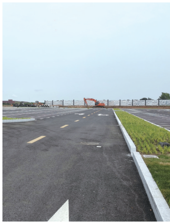
明溪路周边配套停车场
