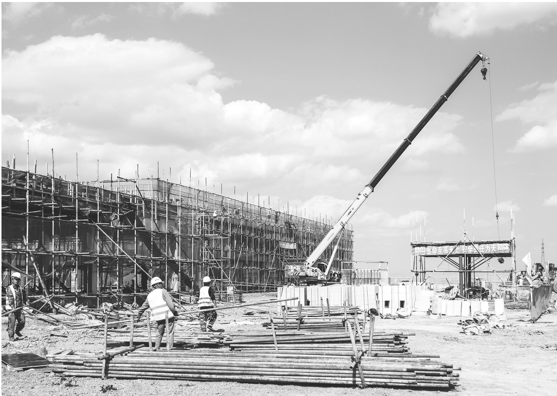
上海电气洮南市风电耦合生物质绿色甲醇一体化示范项目,是白城市绿电制氢氨醇代表性项目,是全省28个百亿级项目之一。项目计划总投资224亿元,整体打造100万吨风电耦合生物质绿色甲醇一体化基地,该项目分三期实施,目前一期正在紧锣密鼓施工中,全部达产后,年产值可达48亿元,税收5.8亿元。
